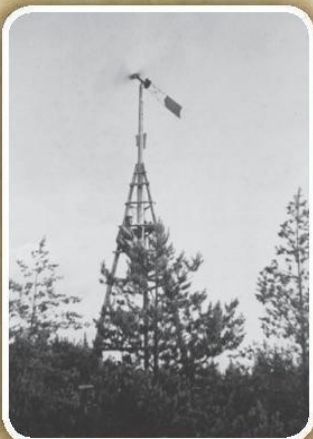
Электричество от ветровой энергии, разработанной в 1940-х годах Аарне Юли-Кайтала
